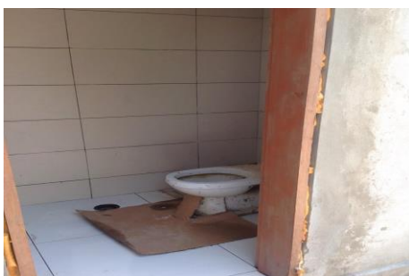
Figura 6. Instalação Sanitária do Canteiro A.
