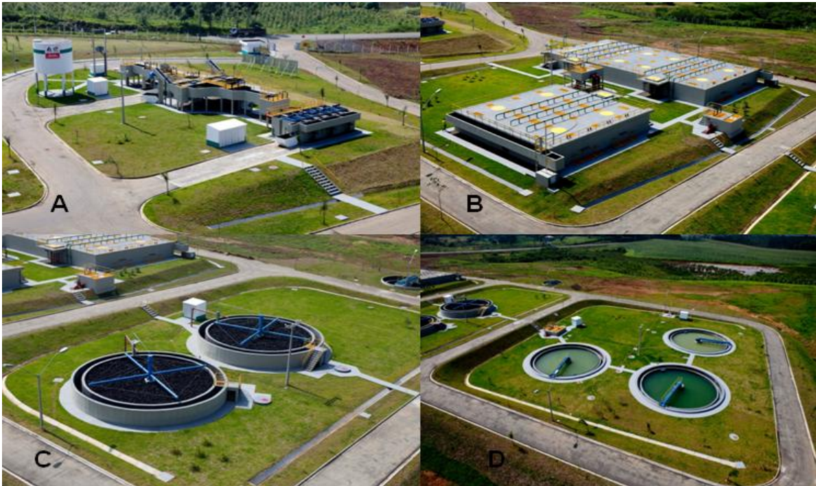
Figura 7 – Etapas do processo da ETE. a) Tratamento preliminar; b) Reator UASB; c) Filtros Biológicos; d) Decantadores secundários
