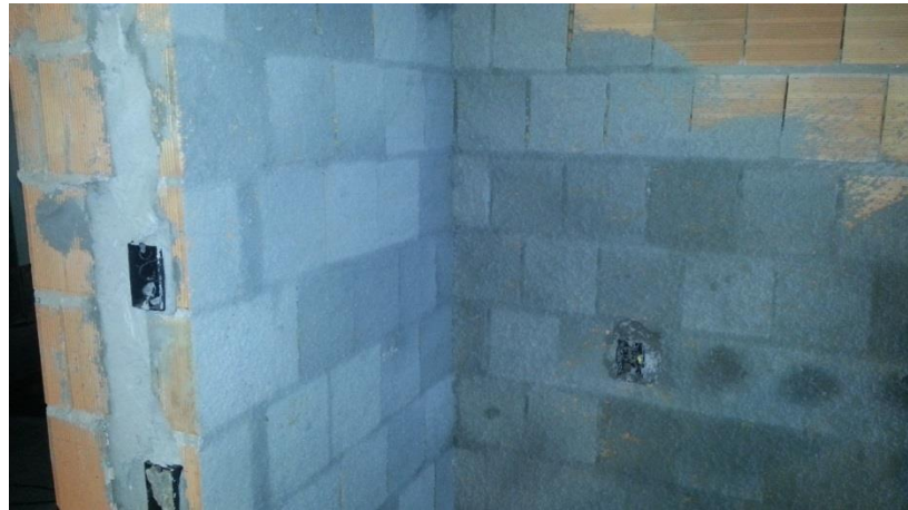
Figura 1: Parede com chapisco.
